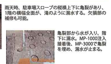
駐車場スロープ漏水防止処理
