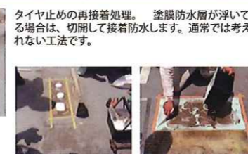
駐車場タイヤ止め接着処理
