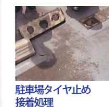
タイヤ止めの再接着処理。塗膜防水層が浮いている場合は、切開して接着防水します。通常では考えられない工法です。
