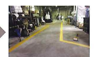
亀裂はMP-1000、またはMP-3000で下処理を施す。 左：施工中 右：MP-13樹脂モルタル塗り完了
