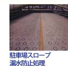
雨天時、駐車場スロープの縦横上下に亀裂があり、1階の横幅全面が、滝のように漏水する。欠損部の補修も可能。 亀裂部から水が入り、階下に漏水。MP-1000注入接着後、MP-3000で亀裂を埋め、漏水が止まる。
